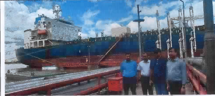
চিত্র-১: কমিটির সদস্যগণ এমপিএল এর ডলফিন জেটি-৫ (DOJ-5) এ আমাদনিকৃত জ্বালানি তেল খালাস কার্যক্রম পরিদর্শন করেন।
